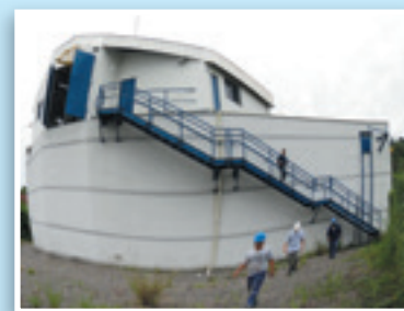
Dique da Fortaleza deve ser concluído esse ano
