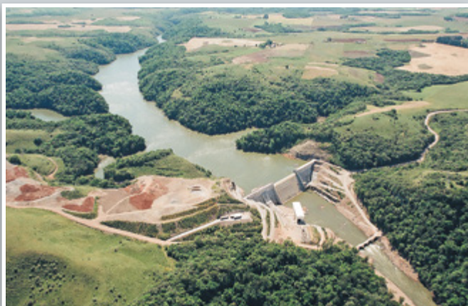
PCH Engenheiro Henrique Kotzian, situada nos municípios de Júlio de Castilho e Salto do Jacuí (RS)
